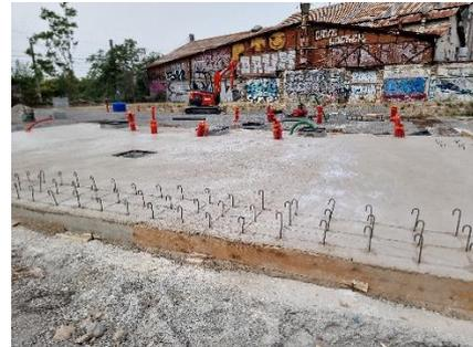
Sollicité pour créer un site de dépôt de bus temporaire à Marseille pour la RTM, les équipes Travaux de GCC Provence et la Direction Technique de GCC ont saisi cette opportunité pour lancer une série de tests sur la résistance, la durabilité et le comportement dans le temps du premier béton H-UKR d'Hoffmann Green Cement Technologies réalisé avec des granulats recyclés Néolithe. L'élément ciblé pour le test est la dalle de l'aire de chargement carburant.
